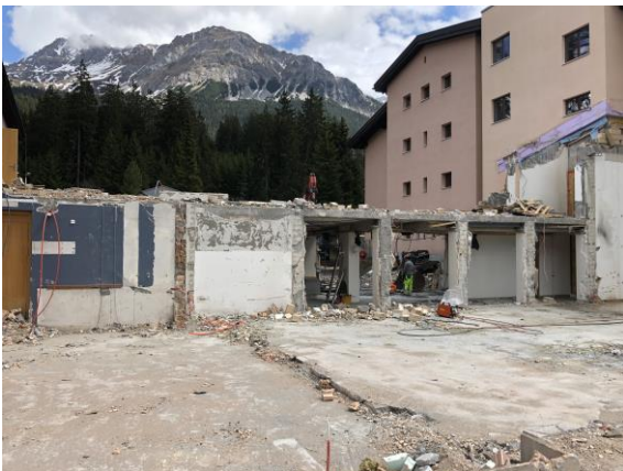
Rückbau des Mittelteils zwischen Primar- und Oberstufentrakt
