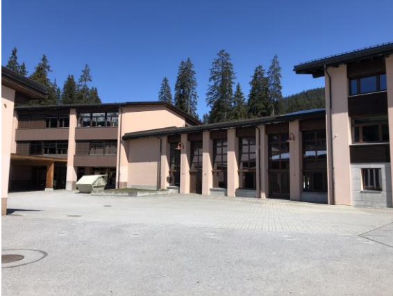
Fassade, vor und nach dem Umbau
