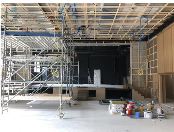
Bauphase, jedes Detail ist wichtig
